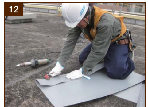
12 （立上り用防水シート前処理） 立上り用の POLYFIN3018 は、あらかじめ出隅、入隅部分を若干加熱し折り目をつけておきます
