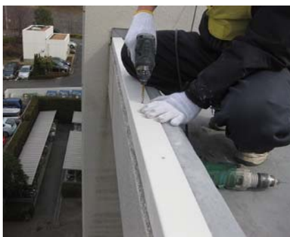
POLYFIN 専用鋼板の取付け
