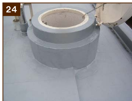
(施工完了) ハッチ ウレタン塗膜防水併用
