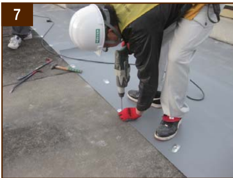
7 （穿孔、機械固定） 引抜試験結果に基づき穿孔、機械固定を行います 固定間隔は @300-400mm
