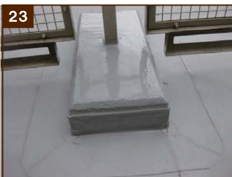
(施工完了) フェンス基礎 ウレタン塗膜防水併用
