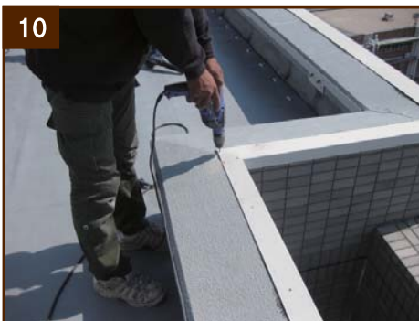
10 （POLYFIN 専用鋼板取付け） 全ての防水端末及び池みを生じる箇所に POLYFIN 専用鋼板を取付けます
