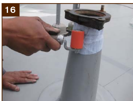
(臭気筒防水処理) 臭気筒端部はポリオレフィンテープを巻き、カスターダッシュフレックスで保護塗装後ステンレスバンドで仕上げます
