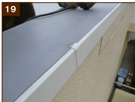
(POLYFIN 専用銅板笠木用ジョイントパッチ処理) POLYFIN 専用銅板笠木用のジョイントは風雨の流入を防ぐため同色のシートでパッチ処理をします
