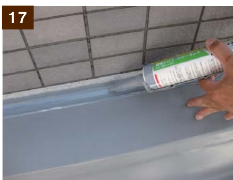
(端部シール処理) 専用プライマー塗布後、端部のシール処理を行います
