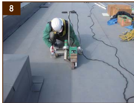
8 （平場自動溶着） 自走式溶着機でジョイントを均一に溶着します
