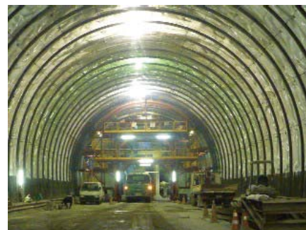
トンネルの防水
