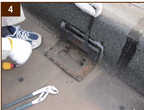
4 （ドレン目皿撤去） 既存のドレン目皿を撤去します 撤去後はカスターリキッドフィルムで仮防水します
