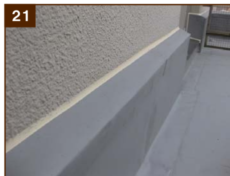
(施工完了) 片笠木天端納め
