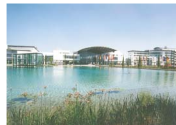
人工池の施工例
