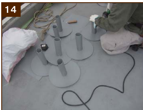
(改修用ドレン製作) ドレンは現場毎に最適な径と長さに調整し製作します
