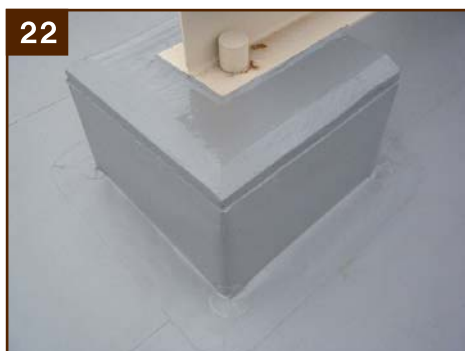
(施工完了) 水槽架台 ウレタン塗膜防水併用
