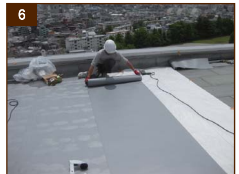
6 （POLYFIN3018 敷設） 水下側から POLYFIN3018 を敷設していきます 下地に凹凸がある場合は絶縁シートを使用し POLYFIN 3018 の損傷を防ぎます
