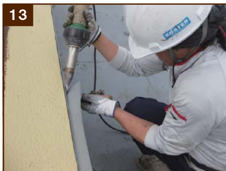
(立上り溶着) 立上りは手動式溶着機で作業をします
