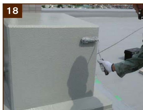
(ウレタン塗膜防水) 鳩小屋や架台は側面に目地を新設し防水端末を納めた後、ウレタン塗膜防水で仕上げます
