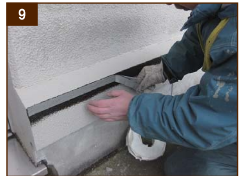
9 （ポリオレフィンテープ張付け） POLYFIN 専用鋼板を取り付ける箇所にガスケットとしてポリオレフィンテープを張付けておきます
