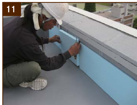
11 （アゴ下充填） アゴ下に PS 発泡材等の下地調整材を充填し平滑にします
