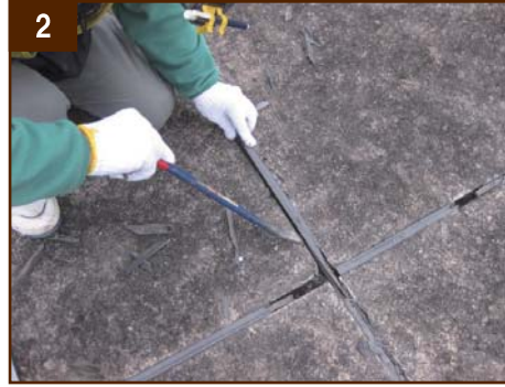
2 （目地処理） 突出した目地材などは撤去し平滑にします
