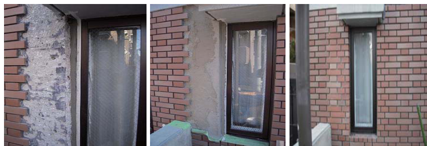
①開口まわりのタイル、シール材を撤去
