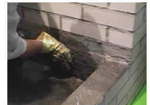
KD2 で仮止水
